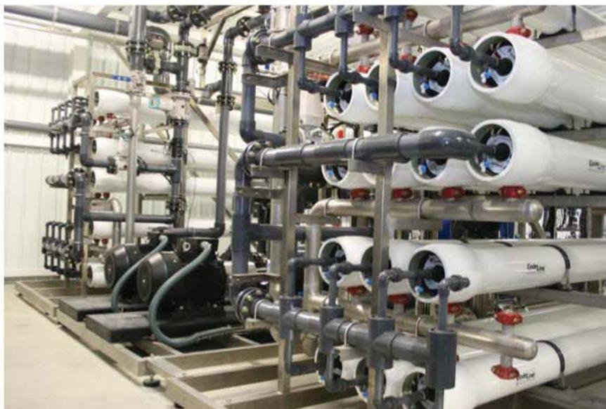
Figura 11. Bastidores de OI y bombas de alta presión
