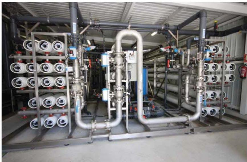
Figura 10. Bastidores de membrana de ósmosis inversa
