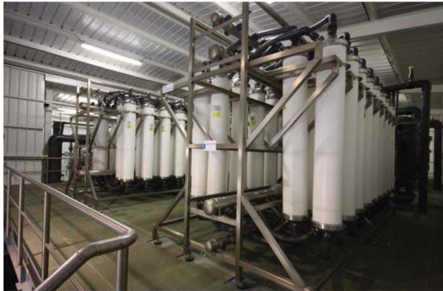
Figura 6. Bastidores de ultrafiltración
