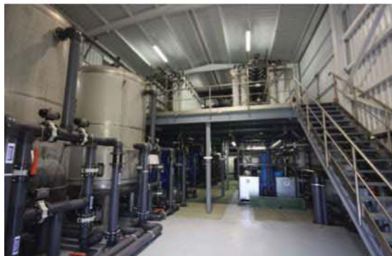
Figura 3. Interior de la nave de proceso
